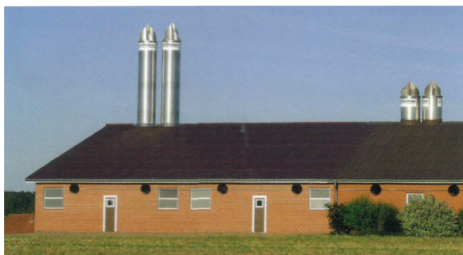
Рисунок 3 – Вентиляційна система для свиноферм – «терморакета»
